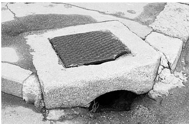
Новые ливневые сооружения строятся на вновь возводимых улицах.
