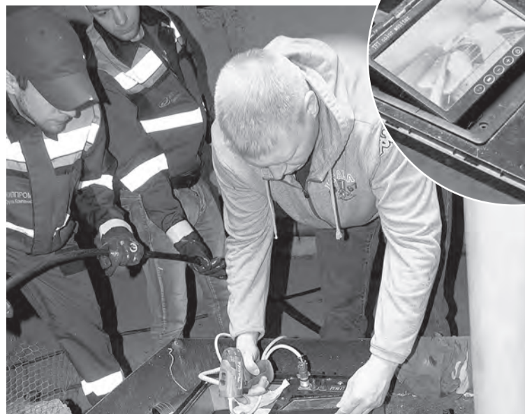
Процесс установления заглушки немного напоминает эндоскопию желудка. Рабочие на мониторе видят трубы изнутри.
