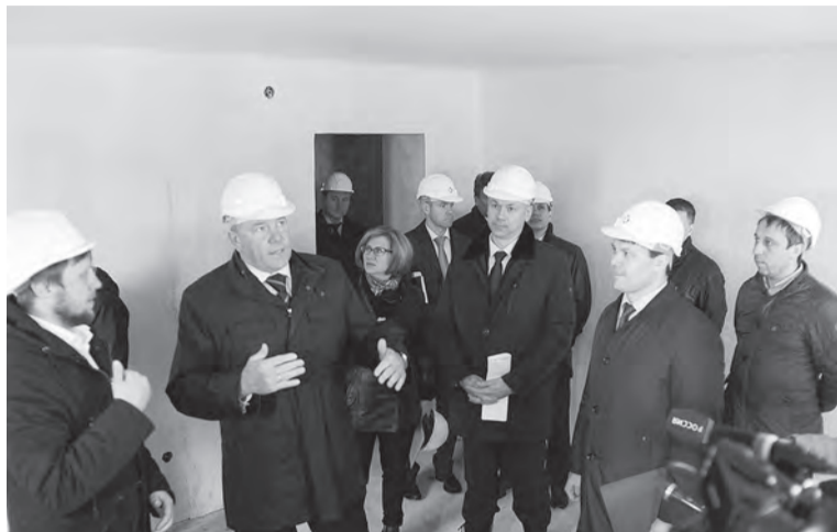
Строители заверили Губернатора, что успеют в срок.
