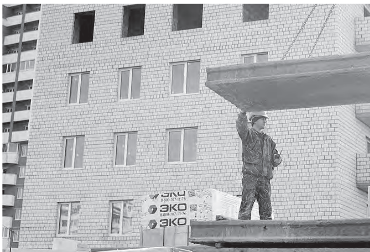
Новый дом для переселенцев на Окружном шоссе.
